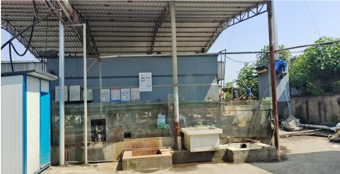
污水处理站照片
