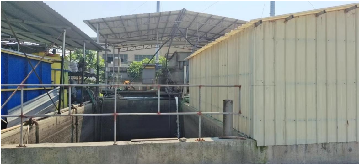
废水收集池照片
