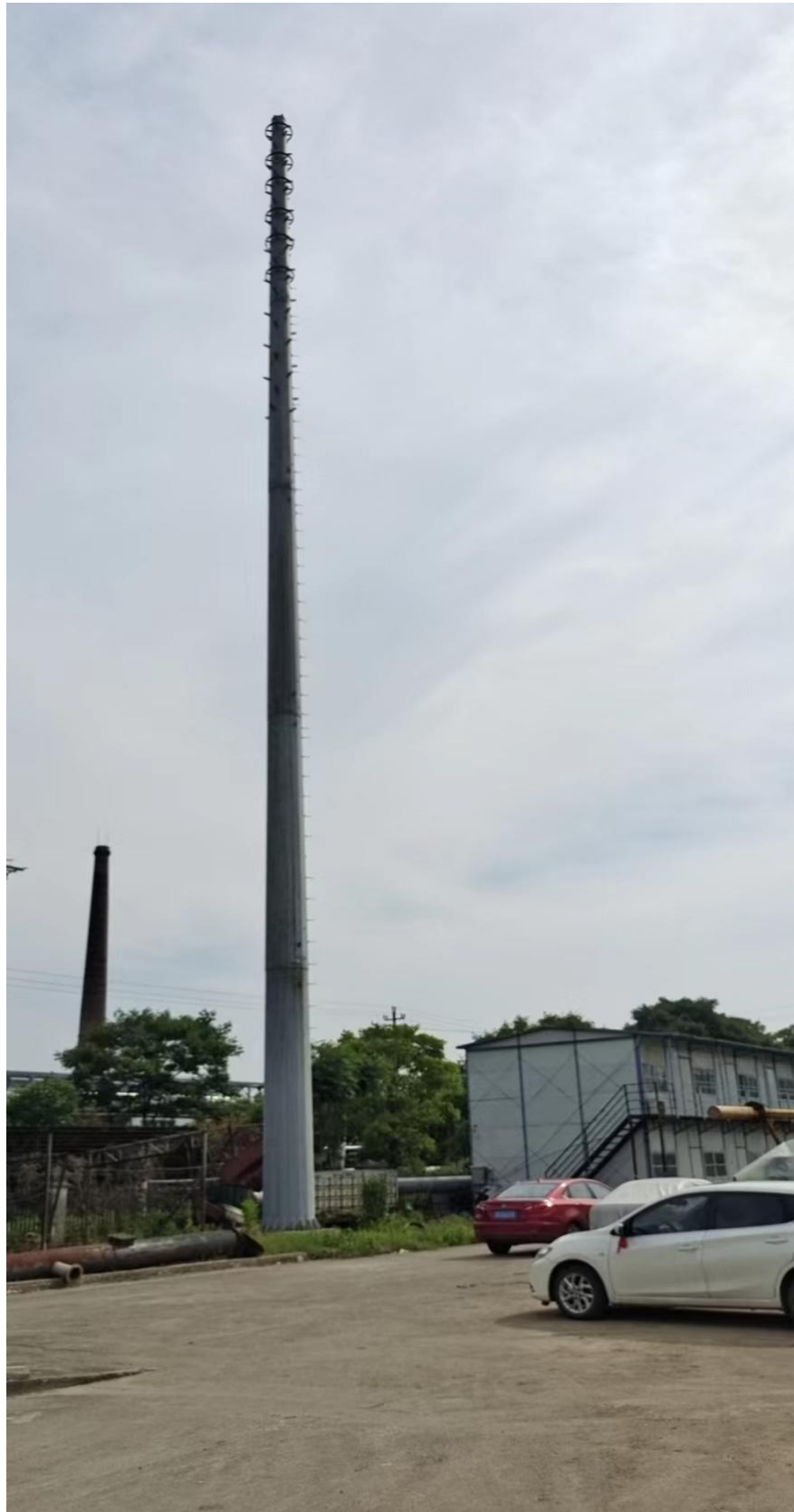
熔融挤出废气排气筒照片
