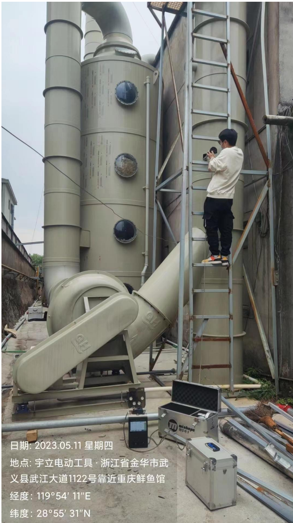
酸洗废气排气筒
