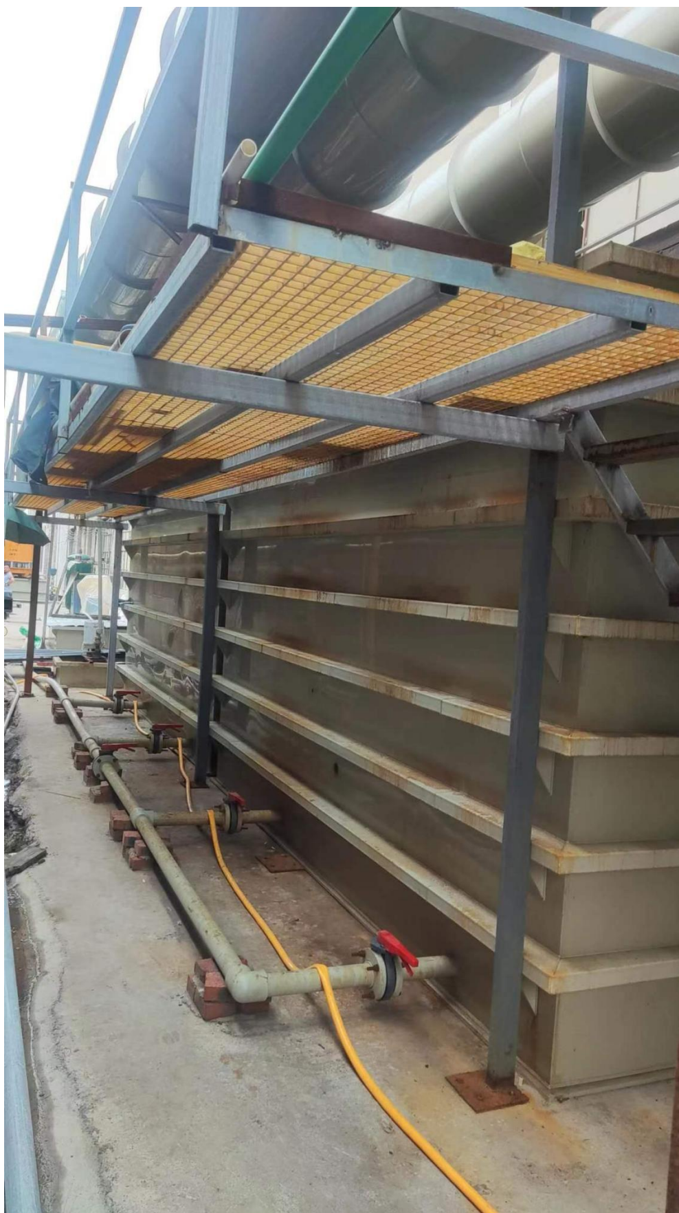
废水处理设施
