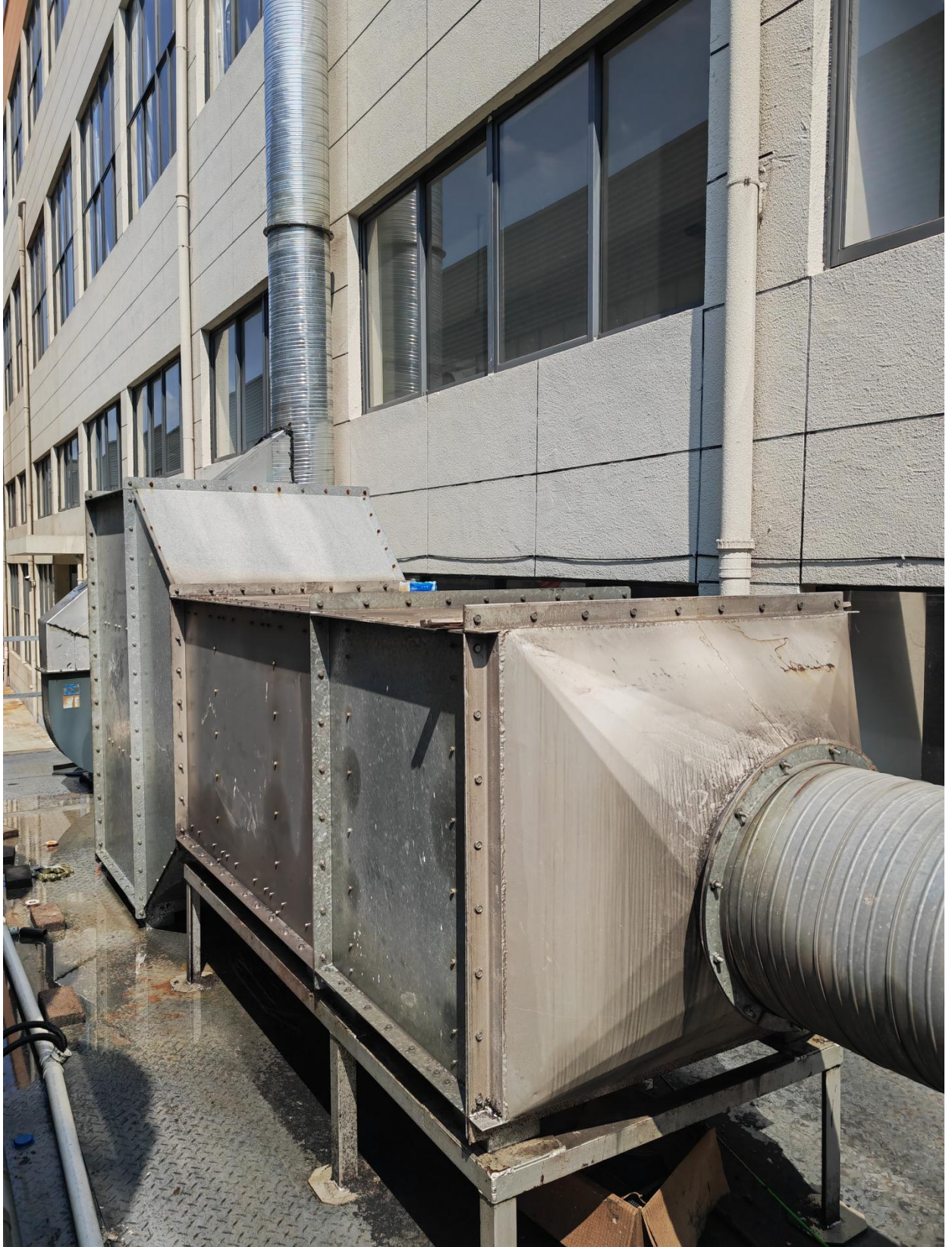
附件6 现场废气治理设施照片
