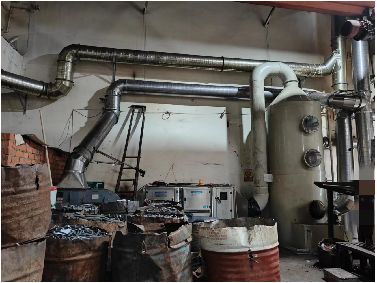
附件 6 废气处理设施照片
