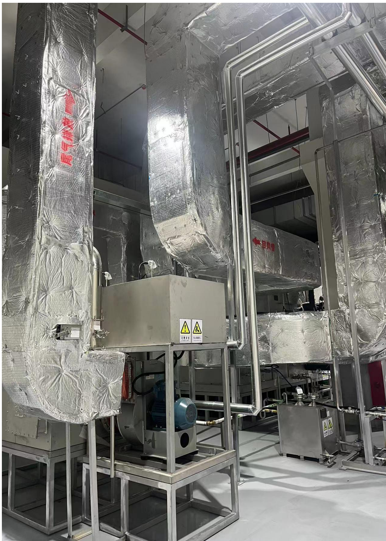
附件 7 涂布烘干有机废气处理设施照片
